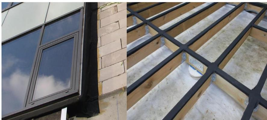
Les strips EPDM sont le système d'étanchéité haute performance idéal pour imperméabiliser, hermétiser et protéger les façades contre l'humidité. Il peut être appliqué sous le bardage extérieur ou autour des châssis de fenêtres. Il offre également une protection contre l'humidité ascensionnelle provenant des fondations du bâtiment. Il s'utilise également en couche d'interposition entre lambourde et platelage bois.
